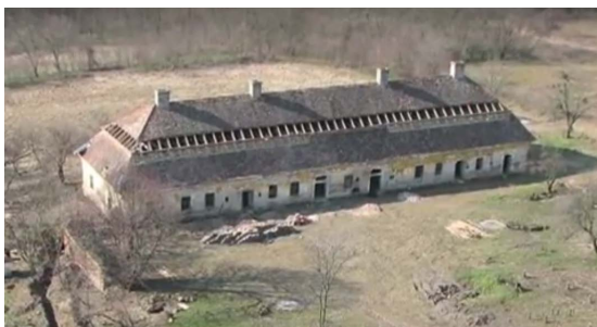
3. kép. A leromlott állapotú épület 5
